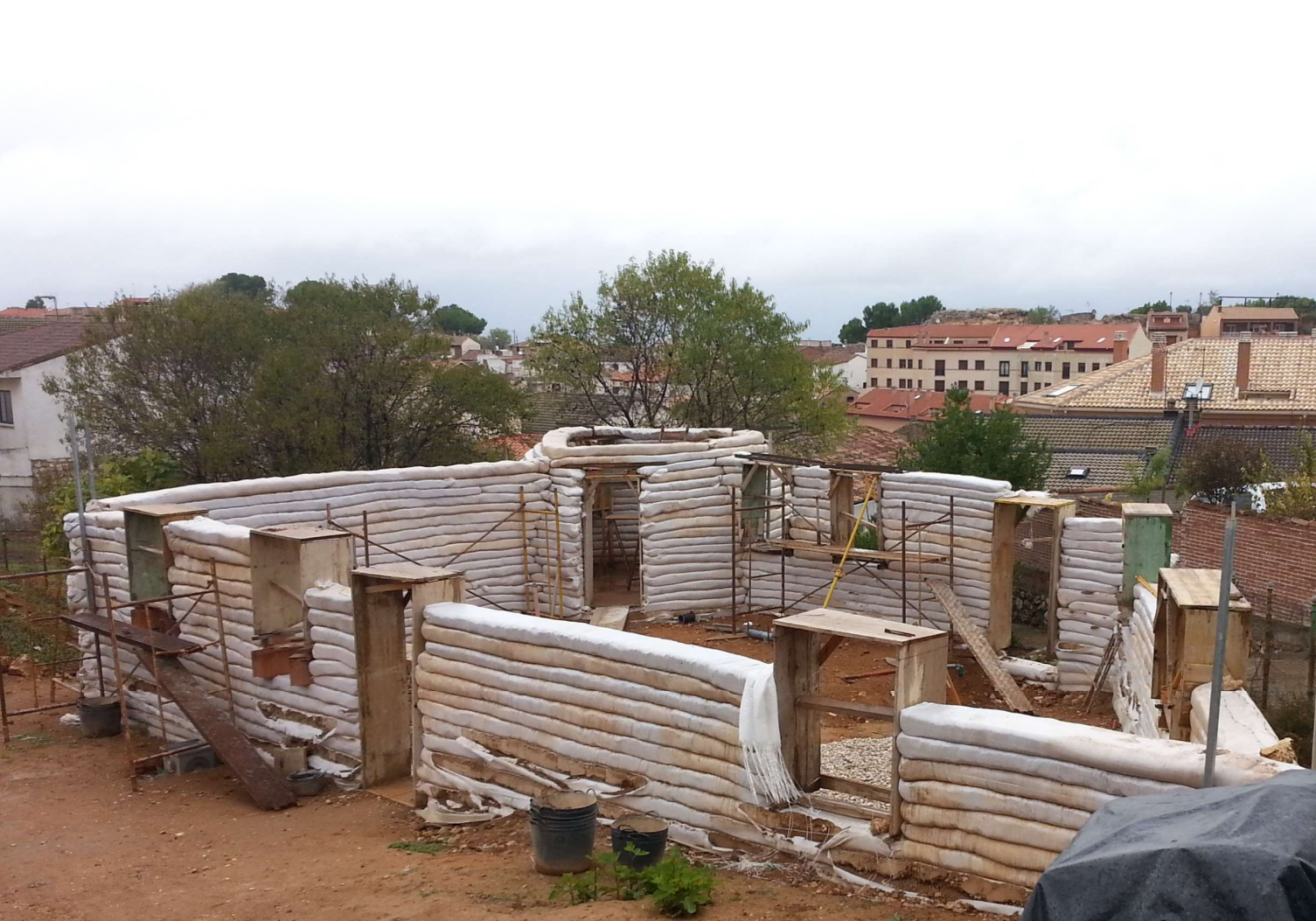
Construcción con hiladas de SUPERADOBE , económica y sostenible
