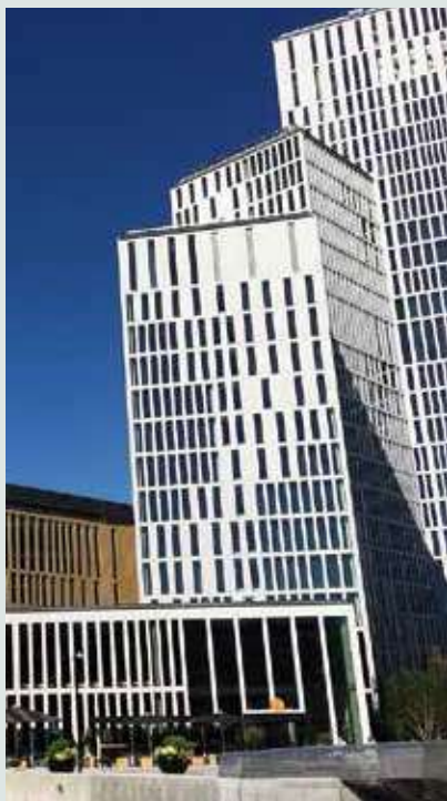
SKANSKA MALMÖ LIVE HOTEL Malmö, Sweden
